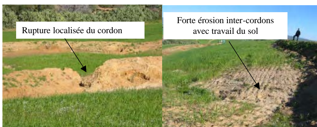
Figure 2 : Photos illustrant les limites de systèmes anti-érosifs en cordons lors d'années fortement pluvieuses, Parcelles de Adnen Abdrabou au Krib
